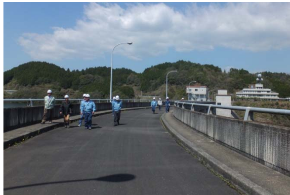
ダム天端広場点検状況
