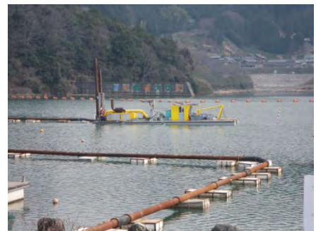
副ダム上流部のマイクロバブル船による浚渫 H23. 1
