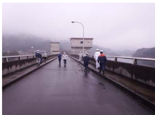
ダム天端広場点検状況
