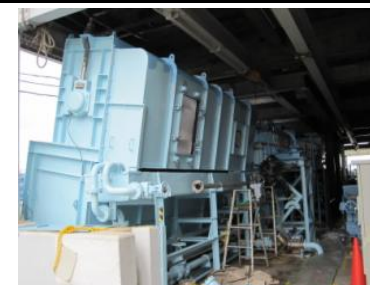
⑭カバー外面塗替塗装中
