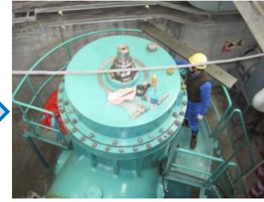
⑪ポンプ本体組み立て中
