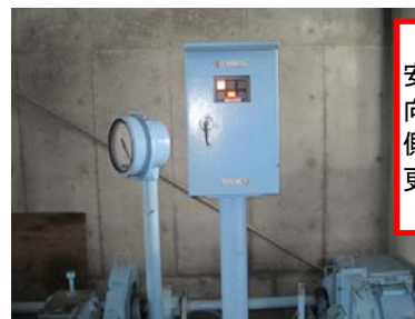
⑭既設機側操作盤
