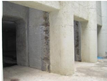
4-①連絡水路の壁面の洗掘状況
