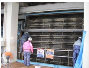
④スクリーンバケット取外し作業
