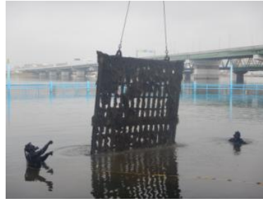
1-①スクリーン撤去作業中
