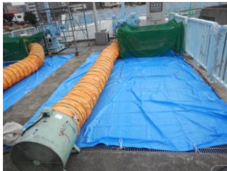
5-②吐出口換気状況
