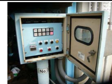
⑮更新予定の機側操作盤
