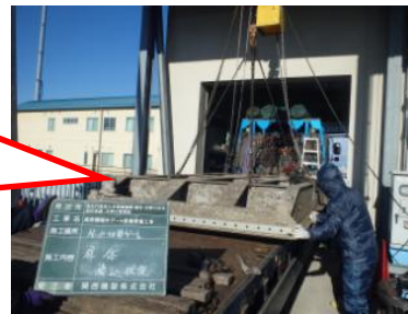
⑩5号・10号扉体工場搬出
