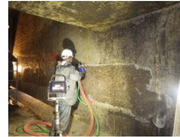
3-③高圧洗浄によるケレン作業
