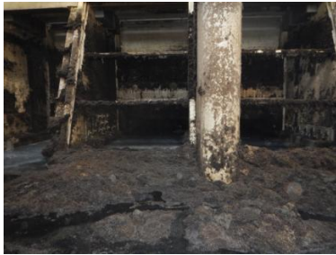
2-①吐出水槽堆積状況
