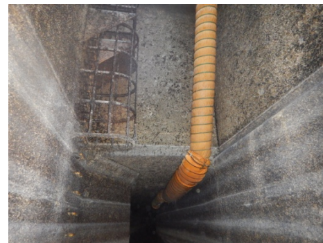
5-③吐出口換気状況
