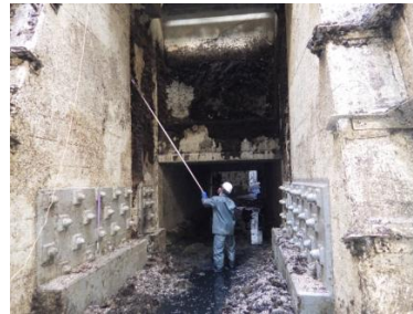
2-②壁面清掃状況
