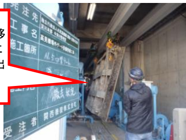
④5号ゲート扉体搬出
