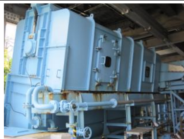
①1号除塵機全景
