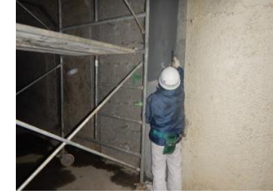
4-④壁面補修作業中
