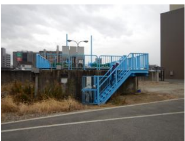
⑬手摺塗替塗装完成
