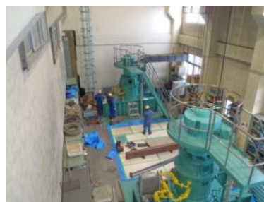
①4号ポンプ全景
