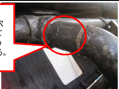
⑫洗浄配管破損箇所(交換)
