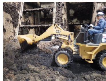
2-③堆積物運搬作業中
