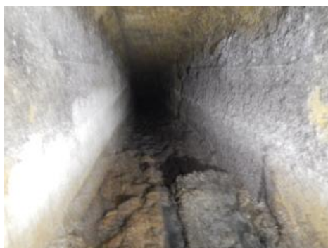
5-⑤六軒家川水路入口側堆積状況
