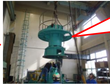
②電動機取り外し移動中
