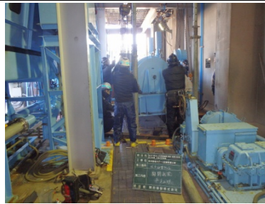
②5号ゲート開閉機移動中
