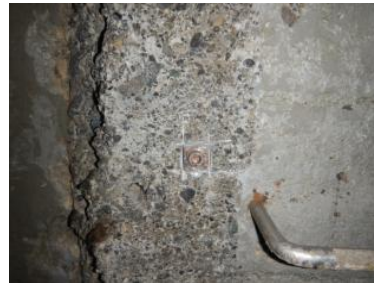
4-②補修部分の拡大
