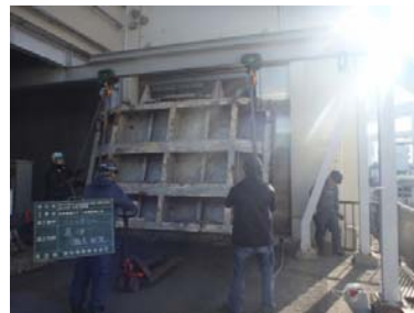
⑤5号ゲート扉体搬出
