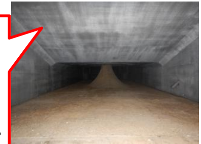
3-④生物付着防止塗装完了
