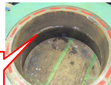
⑩サポート材内面腐食部ケレン中
