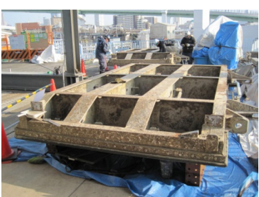
⑨5号・10号扉体清掃
