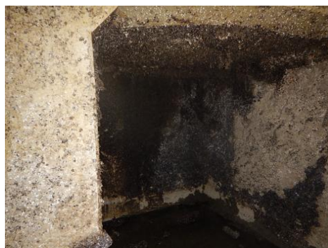
5-⑥下水連絡水路西側ゲート付着状況
