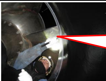
⑫ギャップ測定(インペラとケーシングライフの隙間)
