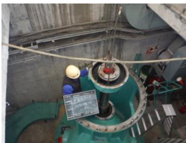
④ポンプ本体分解作業
