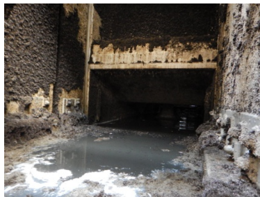
3-①機場付着状況
