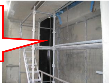
⑪戸当り塗替塗装完了
