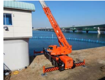
1-②50tクレーンによる撤去作業
