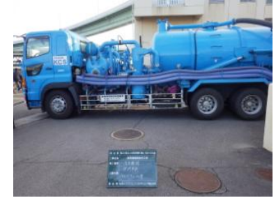
2-④10tバキューム車での回収作業
