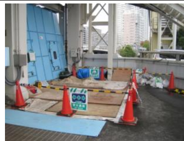
②作業ヤード養生
