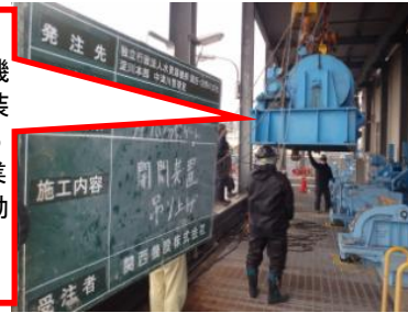
⑦10号ゲート開閉機移動中
