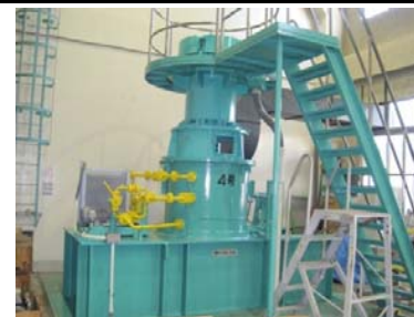
⑮ポンプ整備完了(地上部)
