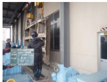
⑧10号ゲート扉体搬出
