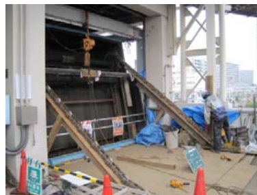
⑤チェーン取り外し作業中
