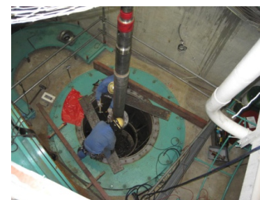
⑥ポンプ軸吊だし作業中
