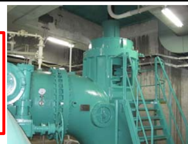
⑭ポンプ整備完了(地下部)
