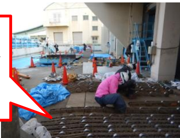
⑥チェーン状況確認作業中
