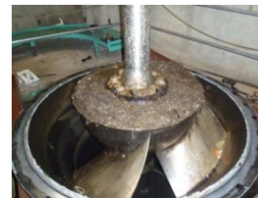
⑦羽根車分解作業中
