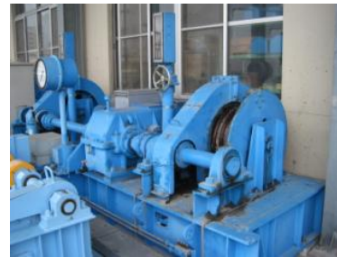
⑥10号開閉機全景
