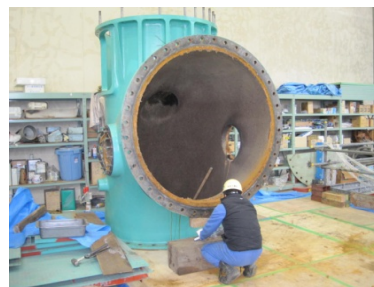
⑤吐出し曲管取り外し
