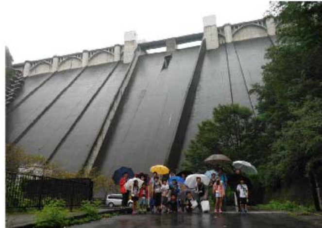
下流より浦山ダムを望む
