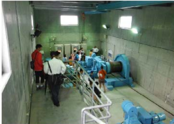
滝沢ダムゲート室
