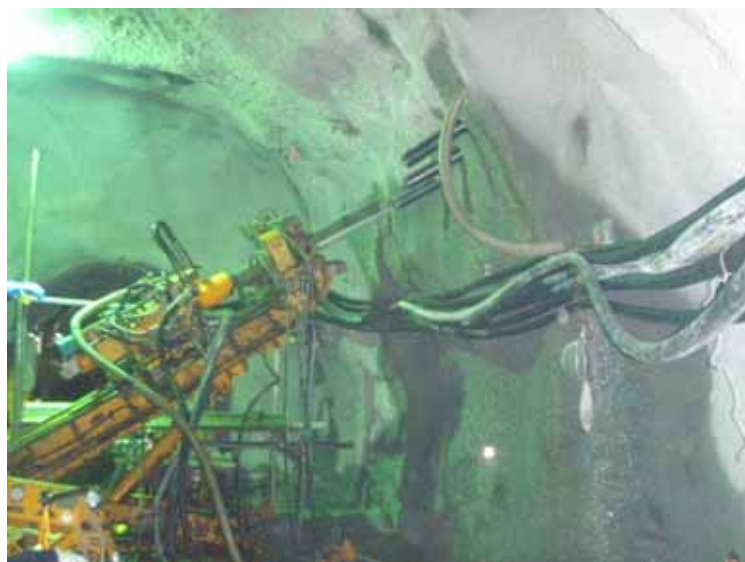
滝ノ沢地区(2次すべり) 排水トンネル (水抜ボーリング施工状況) H23.1
