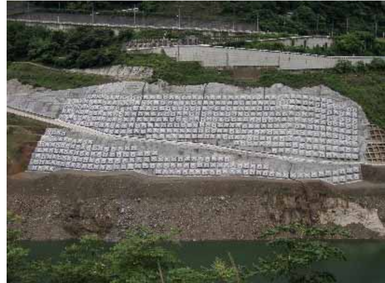
対策工事了 H21.8
