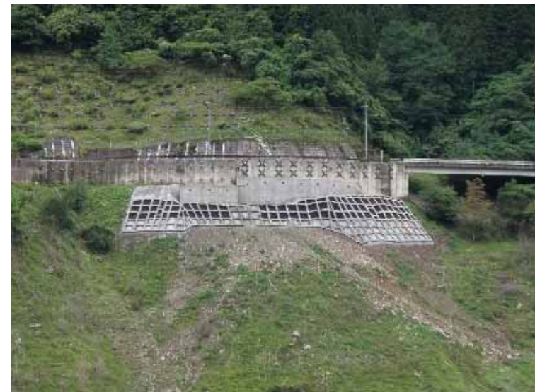
対策工事了 H21.8
