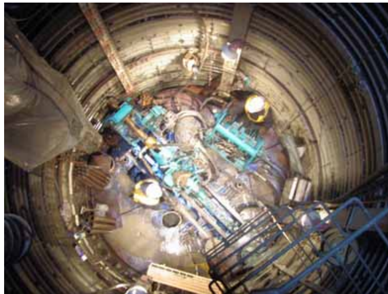
工事実施中 H23.1
