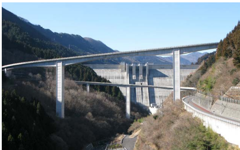
滝沢ダムと雷電廿六木橋
