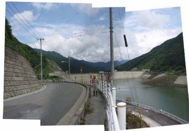
2 2. 国道に変状は認められない。
