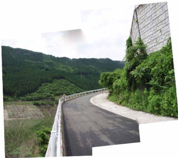
2 1. 道路上に変状は認められない。
