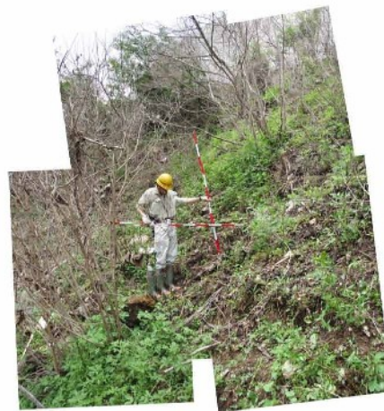
8. 湛水の影射により表層では引きずられた段差が存在する。
