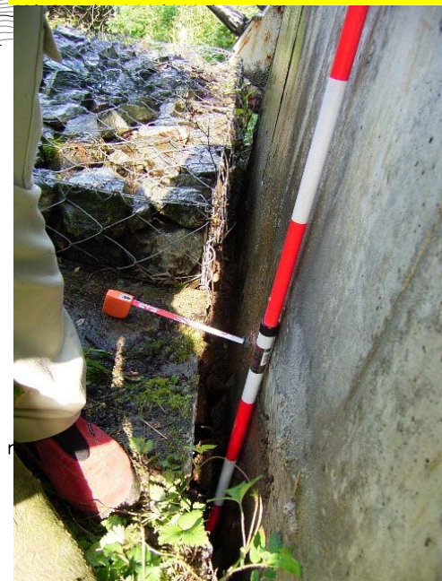
平成20年6月13日 1. 向山上流地区 市道・道路下部斜面の亀裂
