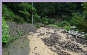
大雨時の土砂流出
