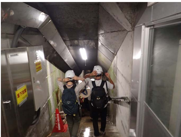
普段入れない監査廊を見学(ダム内見学)
