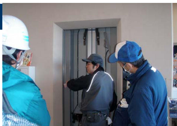
エレベータ扉開放訓練(資料館)
