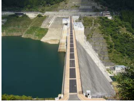
右岸より天端を望む
