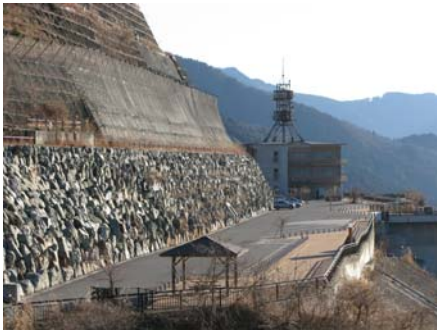
左岸広場（後方は滝沢ダム管理所）
