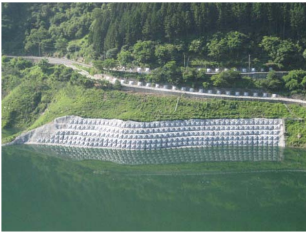
盆栽山地区斜面对策工事箇所
