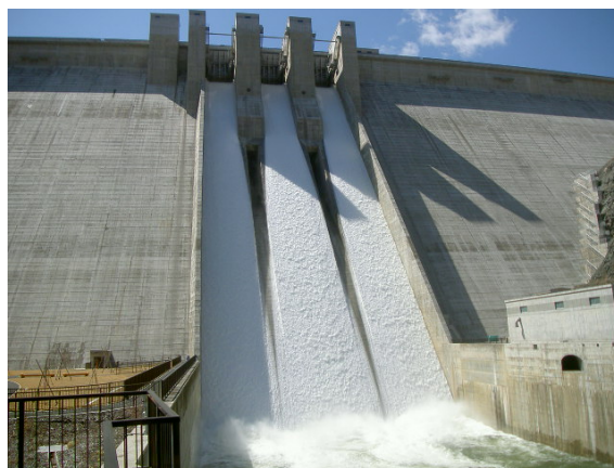
クレストゲートからの放流
