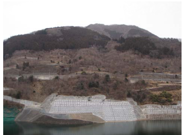
滝ノ沢中央地区斜面对策工事箇所と滝ノ沢集落跡
