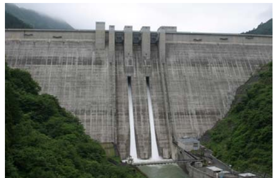
常用洪水吐きからの記念放水状況 (ダム下流から)
