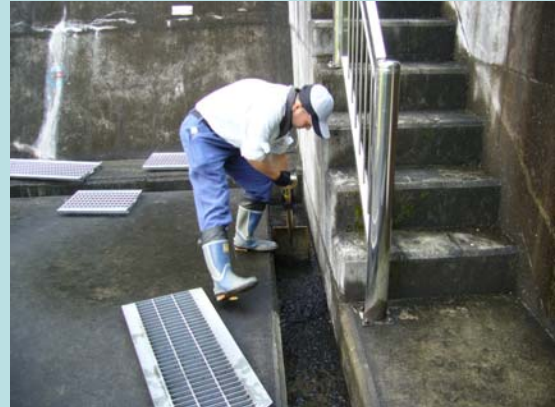
側溝に貯まった泥を取り除いています。
