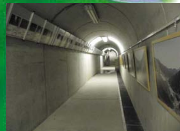
▲C 堤体内部の通路は、 写真パネルが展示さ れています。
