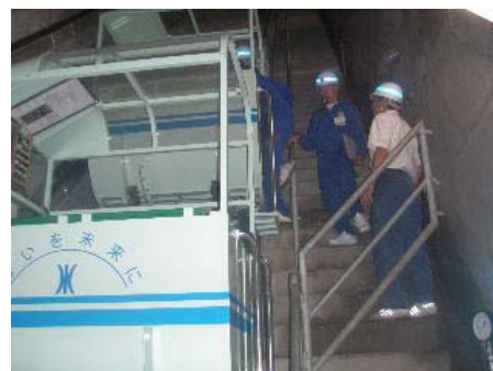
ダムの内部を点検。堤内巡視設備(モノレール)に乗って点検に出発！
