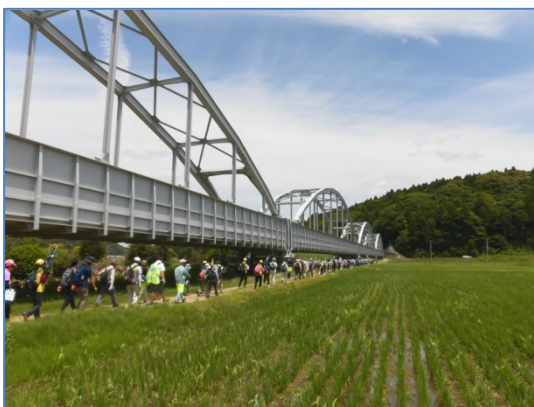
公平水路橋（両総用水）
