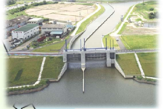
【利根川両総水門】
