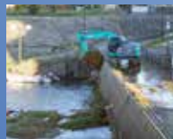
翌日、重機による除去作業
