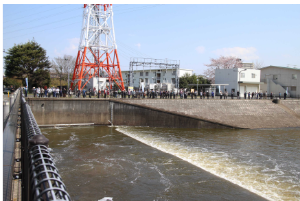
ポンプ試運転の様子
