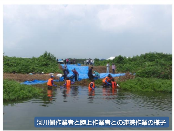
河岸での除去作業の様子
