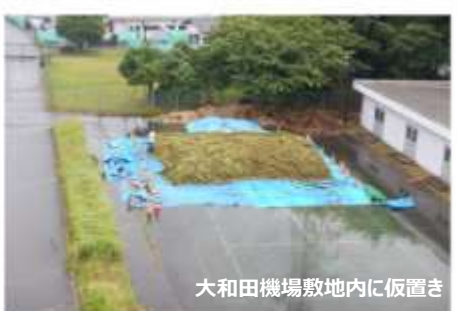
人力による作業風景
