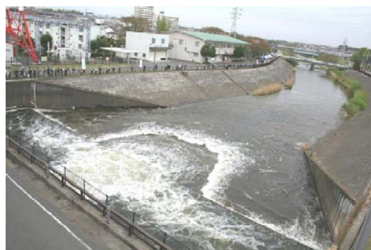
(ポンプ試運転)
