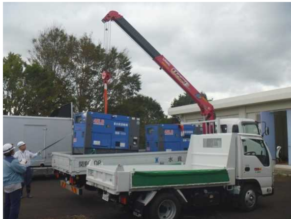
多古町久賀浄水場への設置状況
