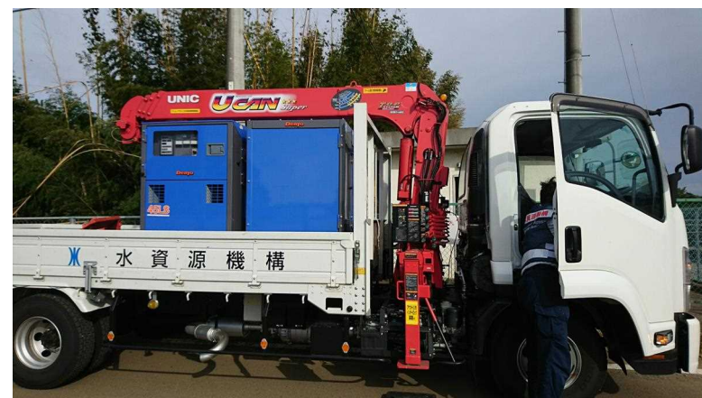
多古町水道・久賀第三取水井への移送
