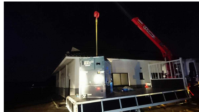
芝山第2クリーンセンターへの設置状況
