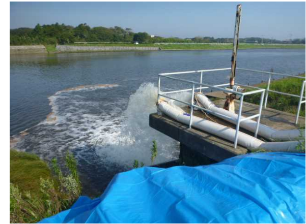
尾形排水機場からの排水状況（10日～）
