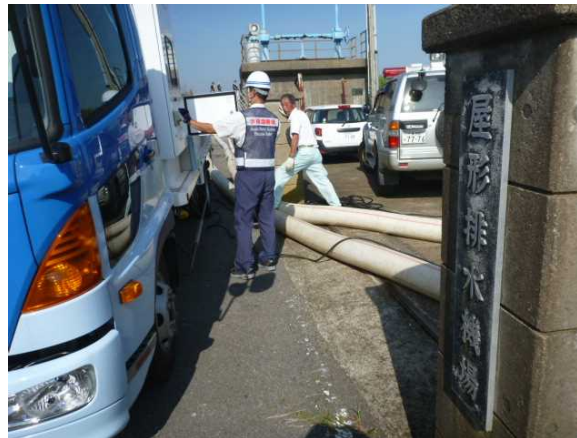
排水ポンプ車設置状況（尾形排水機場）
