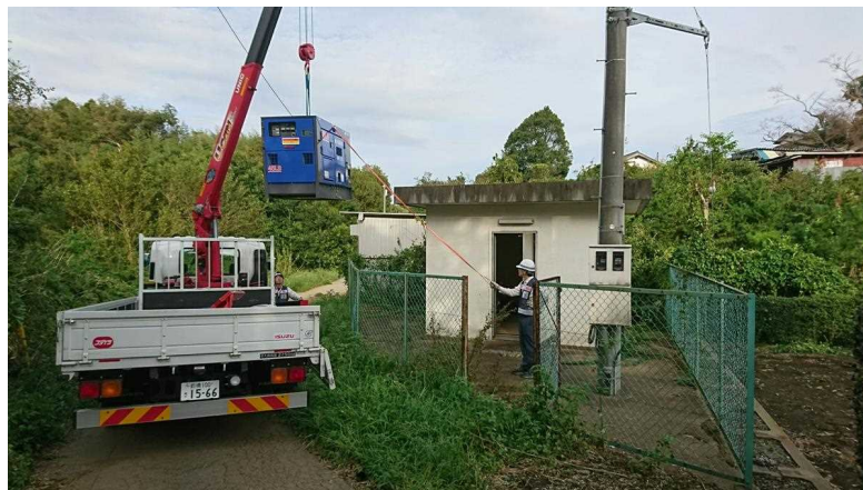
多古町水道・久賀第二取水井への設置状況
