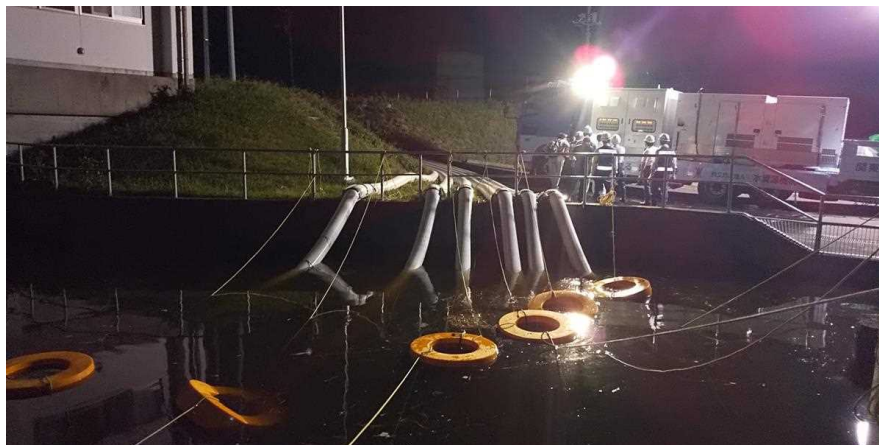
宗吾北機場へのポンプ6台設置状況
