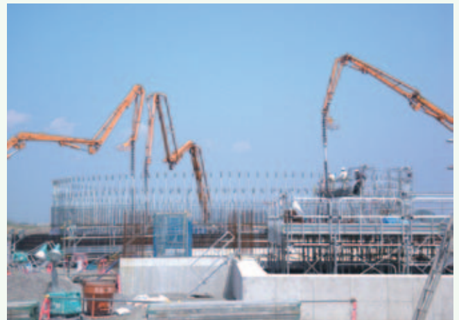
白山甚兵衛機場 吐水槽底版コンクリート打設 (H26.4.25)
