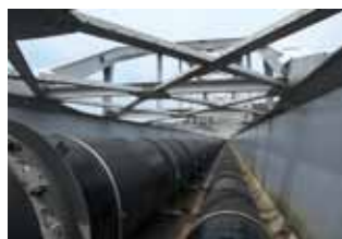
〈公平水路橋（表題写真内部）〉
