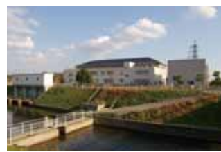
〈第2揚水機場（中央管理所）〉
