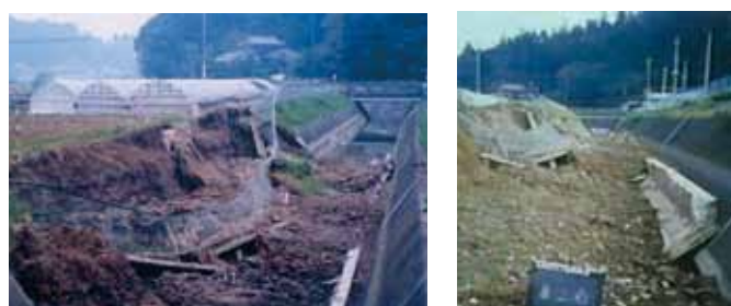
〈地震などによる被害の状況〉
