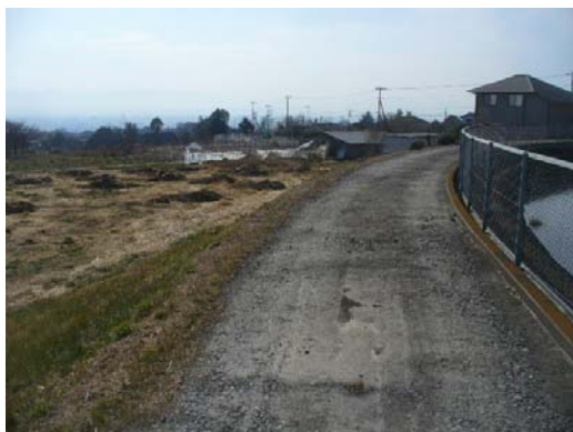
小坂子第5開水路
