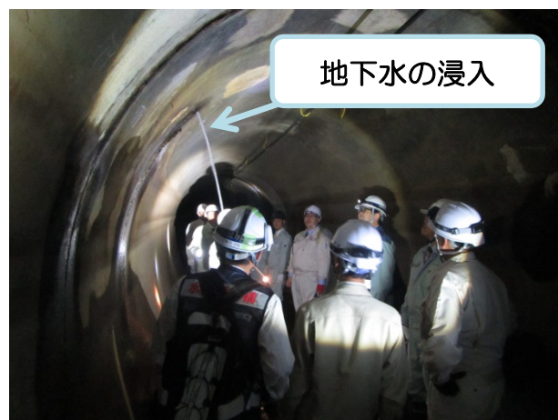
トンネル内の地下水浸入状況です
