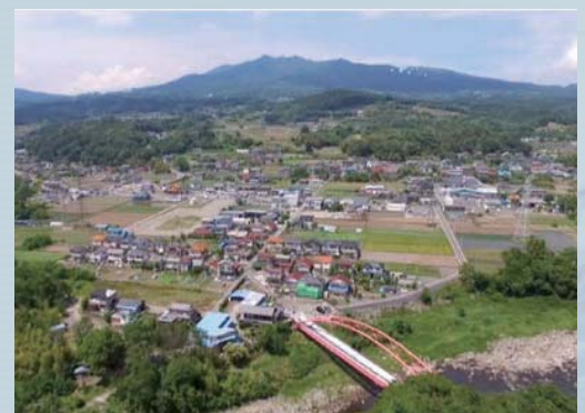
吾妻川水管橋
