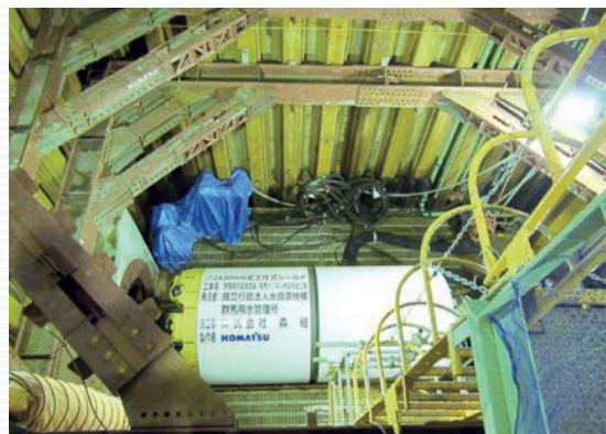
発進立坑内設置
