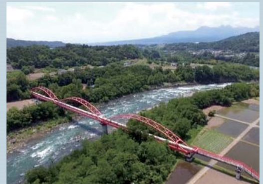
利根川水管橋
