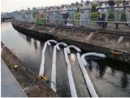
○吸着フェンス展張の完了
