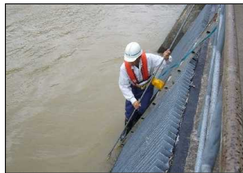
写真 除塵作業状況(9/3)
