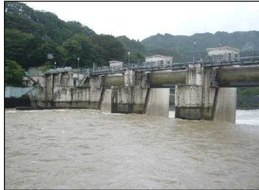
写真 綾戸ダムの水位低下状況(9/3)
