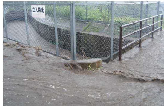
写真 降雨時の状況(9/1) (周辺から集まった水が水路へ流入)
