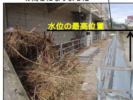
写真 予備取水口の状況 (9/22)
