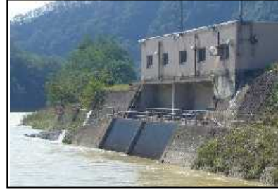
写真 予備取水口(9/25)
