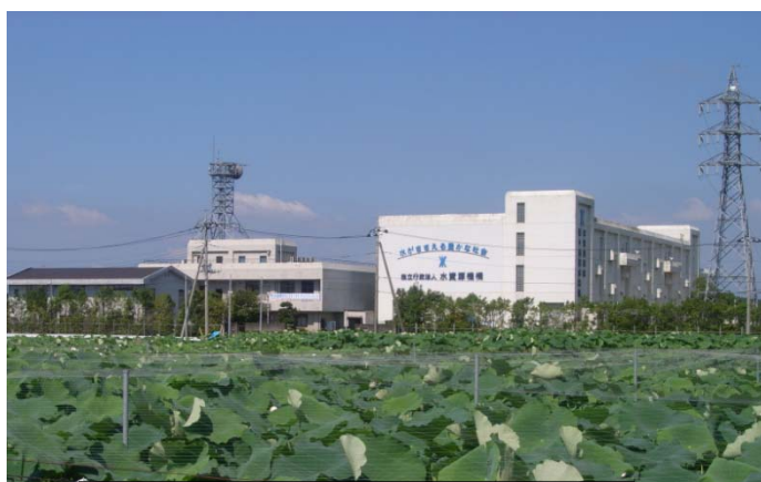
霞ヶ浦揚水機場（右側の建物）
