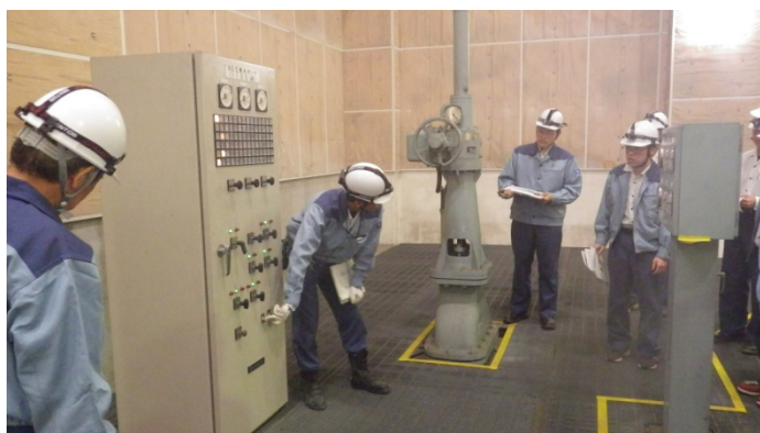
揚水ポンプ操作盤における作業手順の確認
