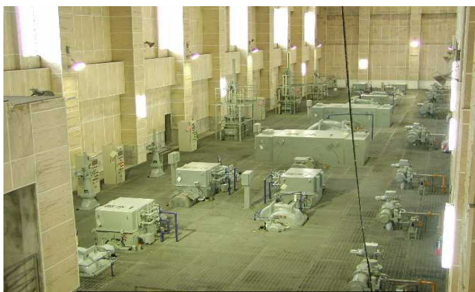
霞ヶ浦揚水機場に設置されているポンプ
