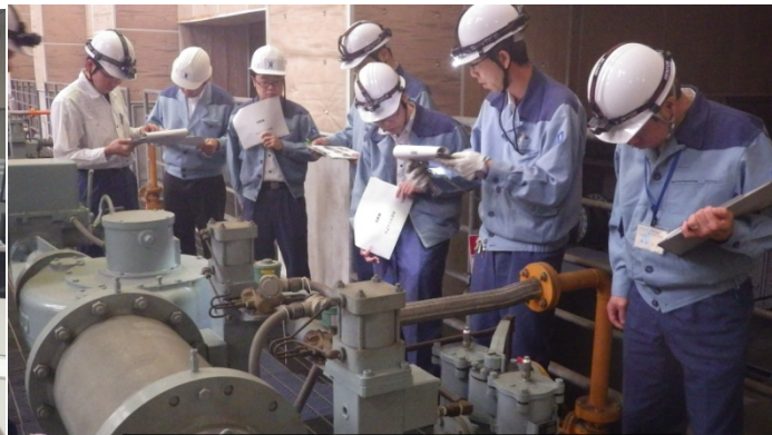
止水弁の操作手順の確認
