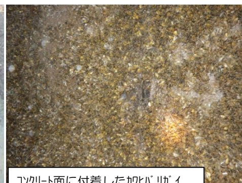
コンクリート面に付着したカワヒバリガイ
