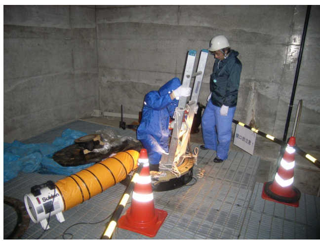
管内入坑状況
