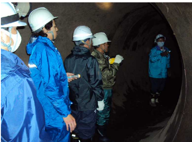
管内視察状況
