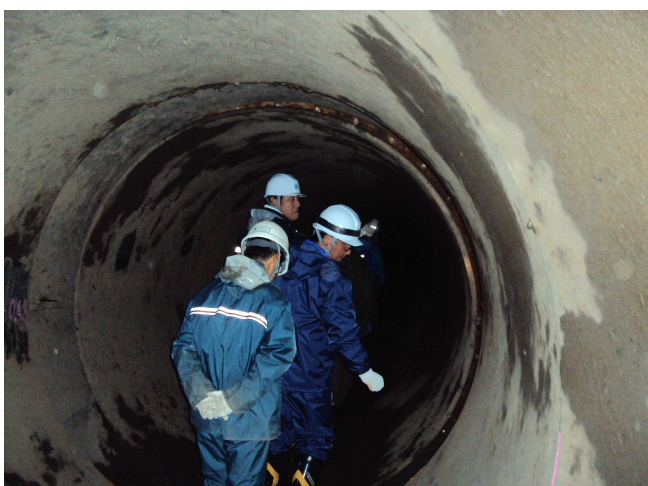
管内視察状況
