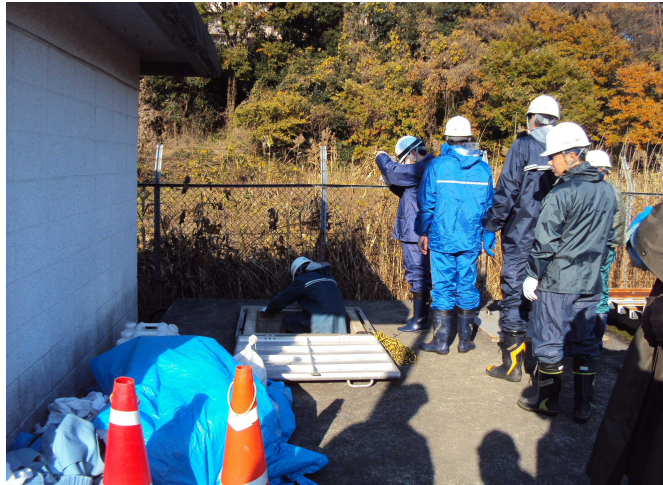
弁室内入室状況
