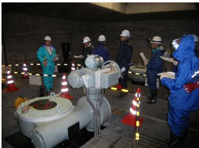
弁室内の施設概要説明状況
