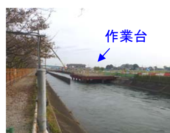
設置された作業台
