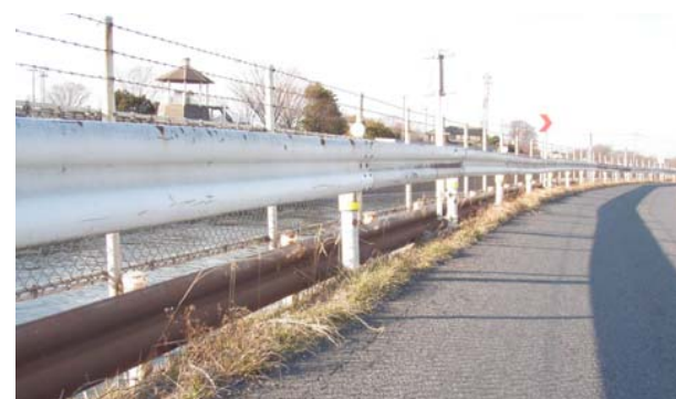
（整備前）歩道のスペースがない状況
