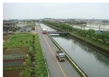
着工前の状況
