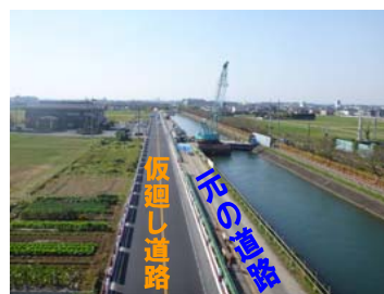
道路の仮廻し状況
