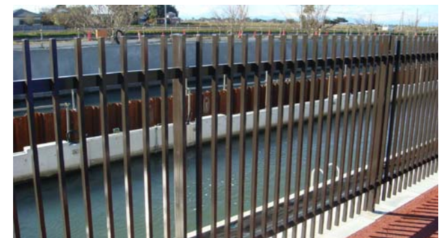
安全性、見通しを確保したフェンス
