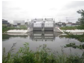
星川水門(新設)
