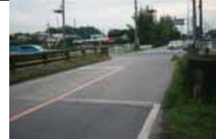
堤根新橋現況
