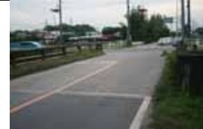
堤根新橋現況
