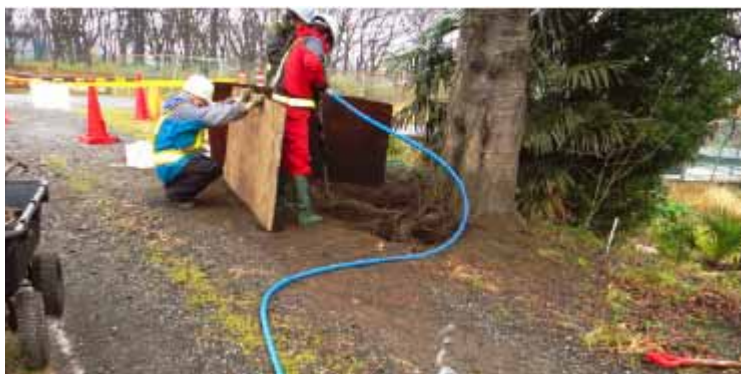
エアースコップ使用状況（飛散防止対策例）
