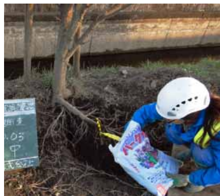
手順 5 ; 良質土（黒土又は植込地用土）にバーク堆肥を 2 割程度混ぜた土で埋め戻しを行う。
