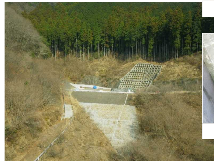
サージタンク工 施工状況 (令和5年4月)
