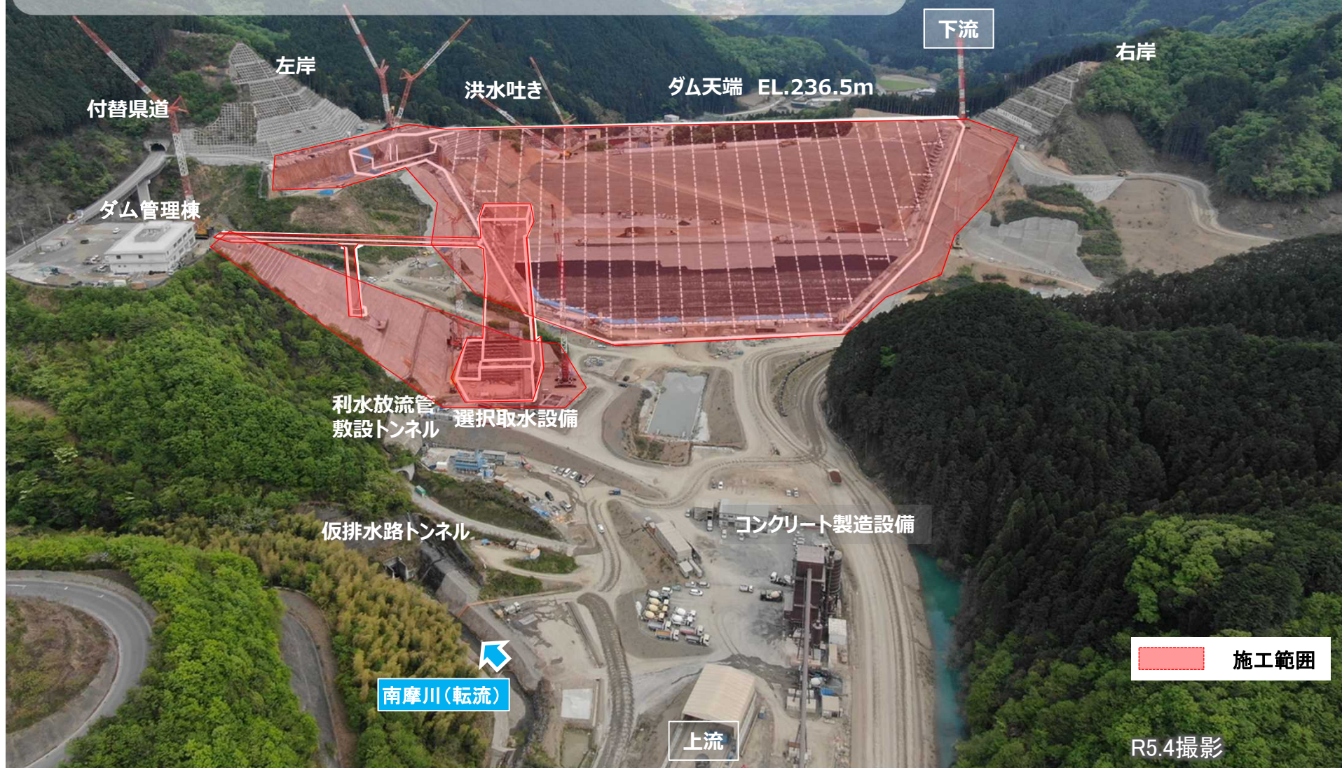
ダム本体等施工状況(堤体上流側から下流方向を撮影)
