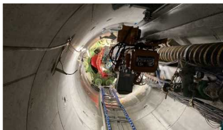
黒川工区 坑内施工状況
