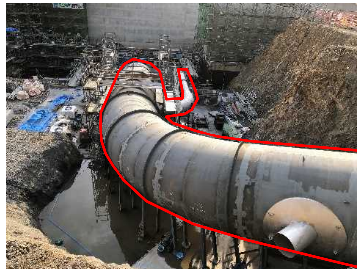
③利水放流管据付 施工状況(令和5年4月)
