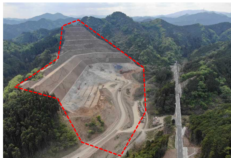
原石山掘削 施工状況(令和5年3月)
