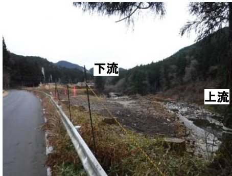
黒川取水放流工 着工前
