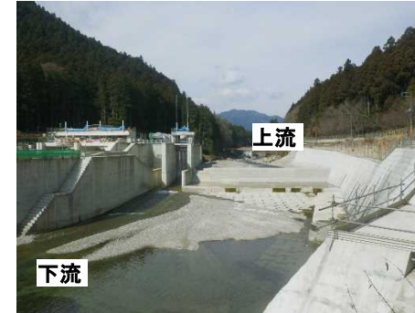
大芦川取水放流工 施工状況(令和5年3月)
