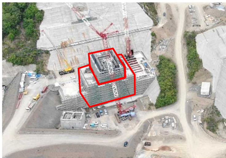
選択取水塔工 施工状況(令和5年4月)
