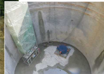
サージタンク内部施工状況
