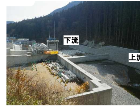
黒川取水放流工 施工状況(令和5年3月)
