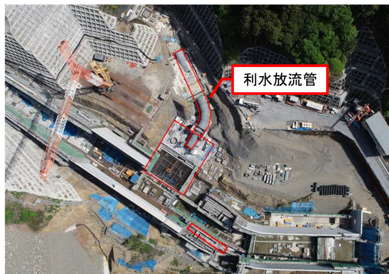
下流明かり部 施工状況(令和5年4月)
