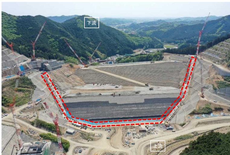
堤体工(盛立)・プリンス 施工状況(令和5年4月)
