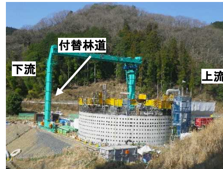
南摩注水工 施工状況(令和5年3月)
