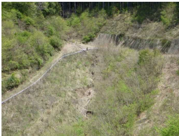
サージタンク工 着工前
