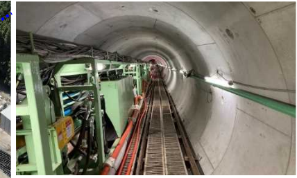
大芦川工区 坑内施工状況
