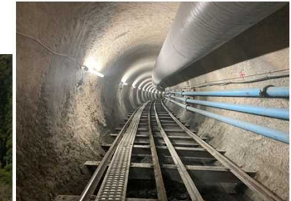
送水路坑内施工状況
