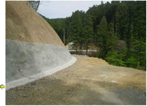
⑪付替林道左岸中流2工区工事 (R4.1.22~R5.10.23)
