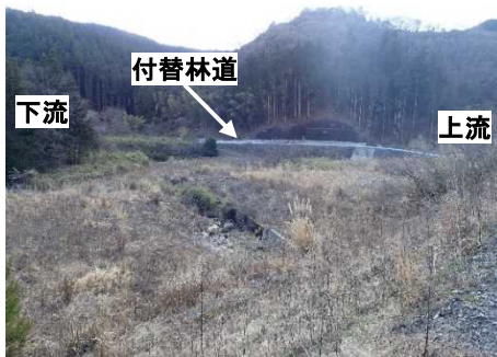
南摩注水工 着工前
