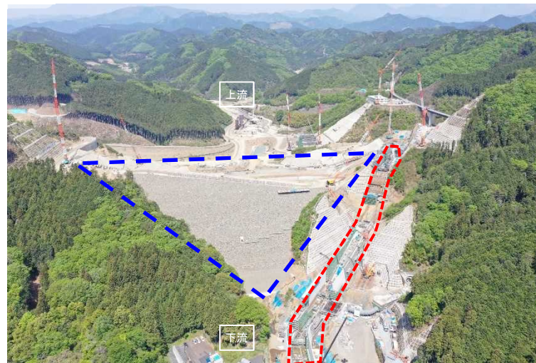
洪水吐工・減勢工 施工状況(令和5年4月)
