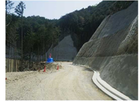
⑥付替林道和田2工区他工事 (R3.12.11~R5.7.23)
