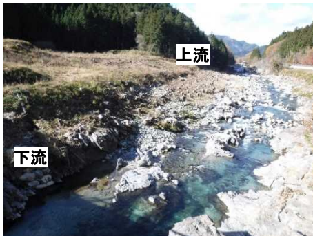
大芦川取水放流工 着工前
