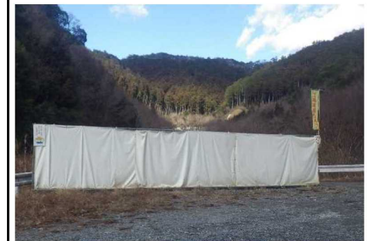
フェンスの状況(R2.1.9)
