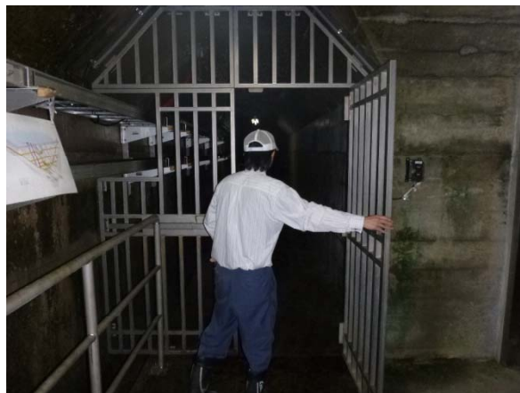
⑧ 格子扉 この先は階段です
