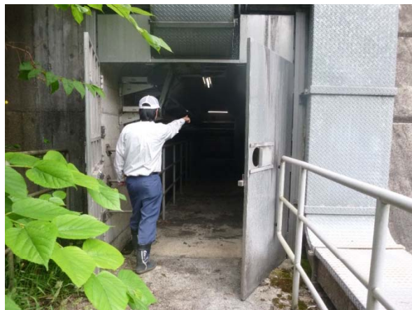
② 補助ダム入口 ダムへの扉があります
