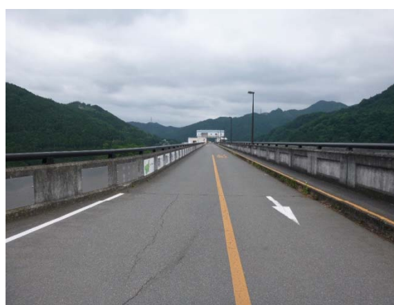
⑰ ダム天端 車に気をつけて！
