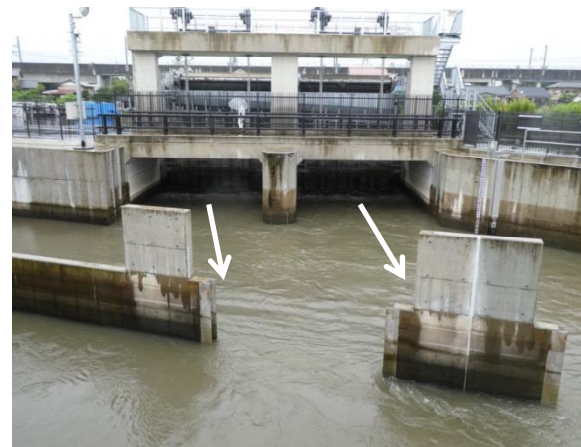
武蔵水路への洪水取込状況(川面水門)
