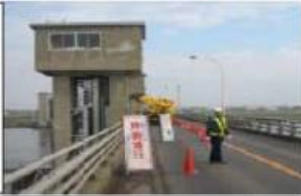
平成16年11月 水門設備整備作業状況
