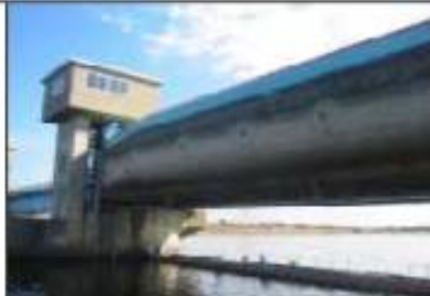
試験後のゲート (ゲート上部の青色部分が今回の試験箇所)
