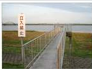
利根川取水口(河口より27km上流)
