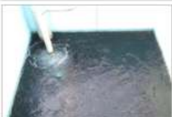
飯島取水場内の急速ろ過池
