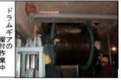
ドラムギアのつり上げ作業中
