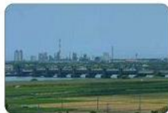
利根川河口堰の全景
